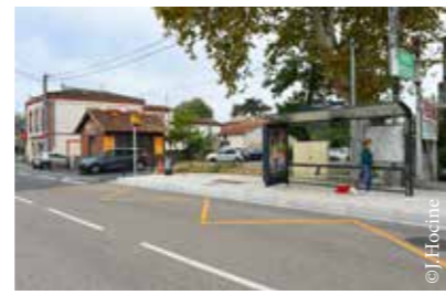
Linéo 3 Mise en place de la ligne de bus entre Tournefeuille et Toulouse.
